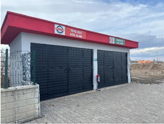
Fotoğraf 5.5. Tehlikeli ve Tehlikesiz Atık Depolama Odalarından Görünüm
